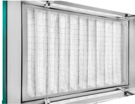
Рисунок 22 (г) Загальний вигляд касетного фільтру в секції
